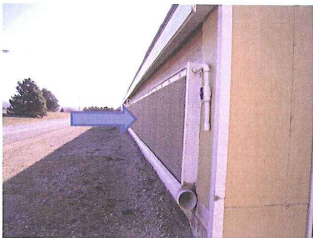
エバポレーションパッド（蒸散パッド）：上部からパッドへ水がしみ込んで、そこを通る空気が冷される
