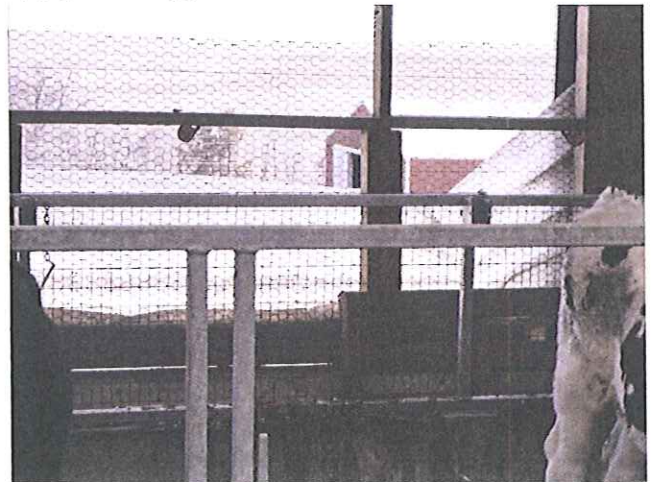
写真8 カーテンが空気断熱になっている コンプレッサーの空気の注入によって 昇降する
