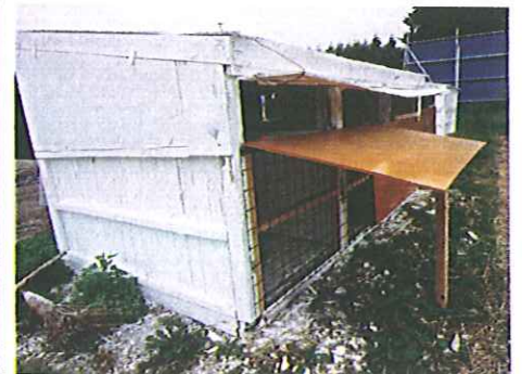
ハッチの奥の壁をメッシュに変更。壁は開閉可能なように改造。
